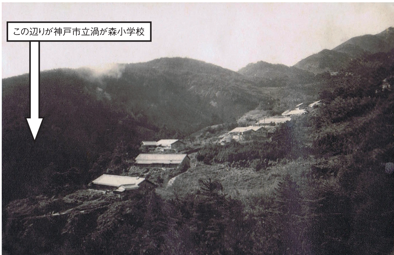
写真⑦ 渦森山を東より。山の上側3分の2は削られてなくなった。建物は水車群。住吉山手9丁目(住吉村字焼ヶ原)。昭和10年(1935)頃
